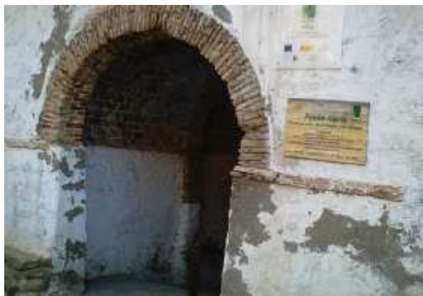
Bóveda de acceso al manantial de Fuente Álamo (A. Alarcón, octubre, 2008)
