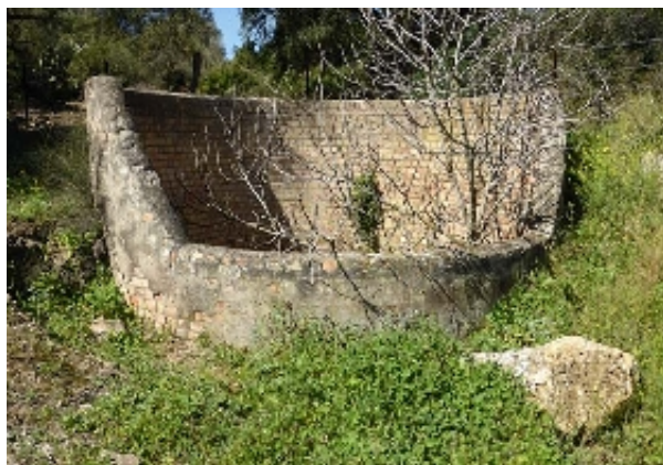
Manantial de Beas con estructura externa de pozo (P. Sánchez Gil, marzo 2015)
