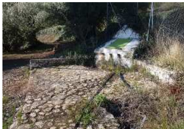
Fuente de Catena Alto (L. Cano Cavanillas, febrero 2015)
