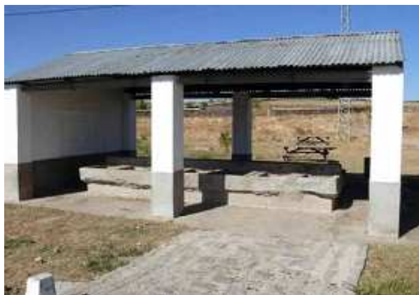
Lavadero público (R. Priego)
