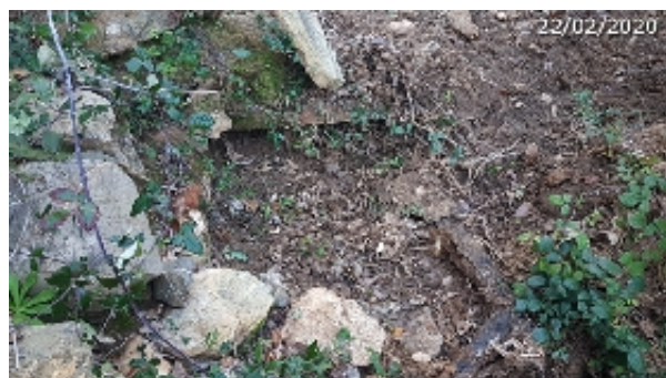
Restos sedimentados de la fuente (A. Ventas. febrero 2020)
