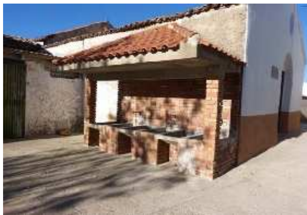
Lavadero de Casas de Carrasco (J. D. Cano Cavanillas, enero 2015)
