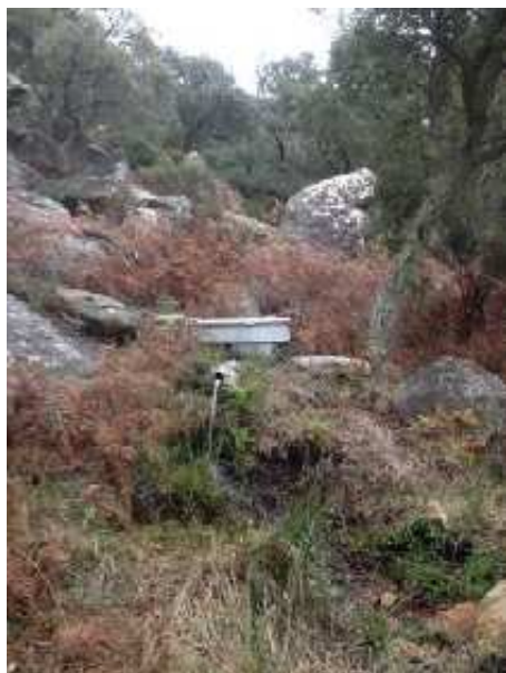
Canuto Largo, sistema de captación (J. M. Fernández-Palacios, diciembre 2014)
