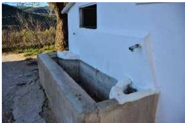
Fuente y lavadero de Ceal (J. Torres Garrido, diciembre 2014)
