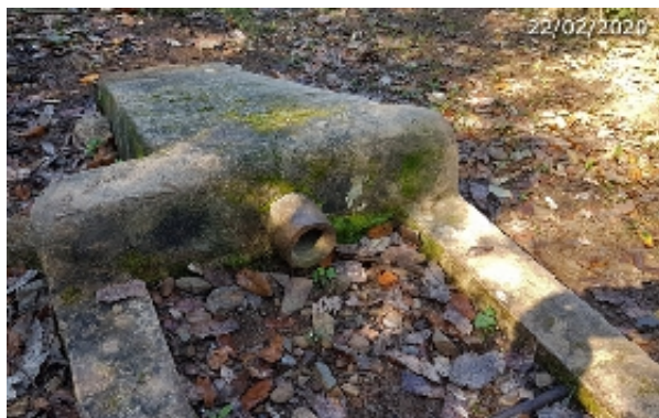
Cabecera del abrevadero del manantial de Las Calderas (A. Ventas, febrero 2020)
