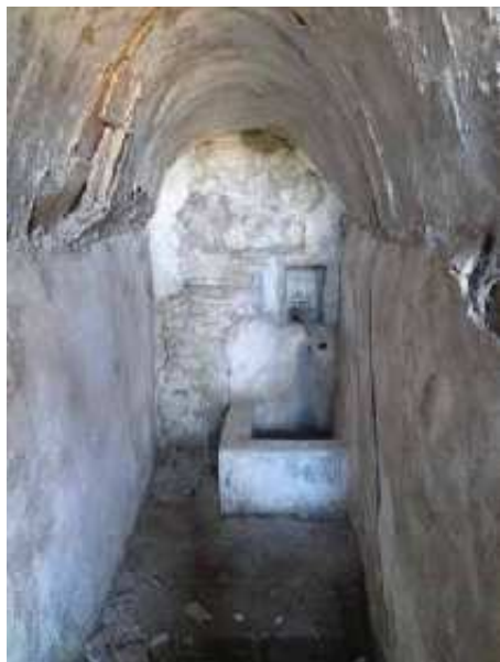
Manantial del Hospital de San Antonio (T. Peinado, noviembre 2014)
