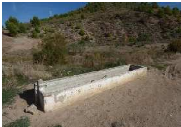
Pilar del Arroyo de Fuente de Blas (L. Cano Cavanillas, noviembre 2014)
