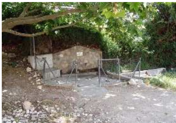
Fuente y abrevadero de los Pastores (A. Montalbán, agosto 2014)
