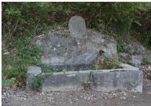
Fuente en la Carretera de las Acebas I (L. Cano Cavanillas, agosto 2014)
