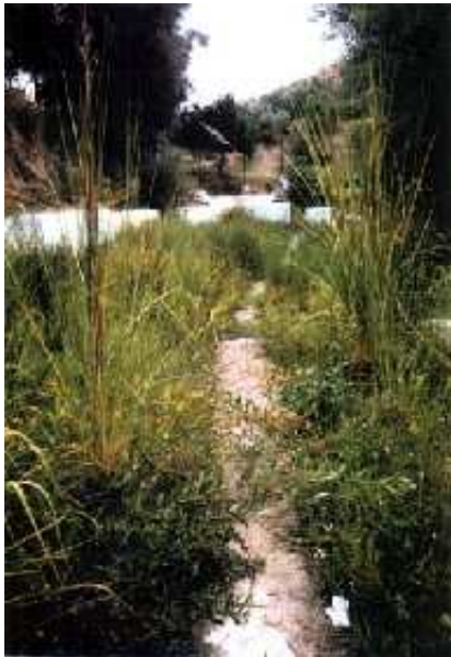
Zanja de drenaje La Rambla (IGME Granada, 1996)
