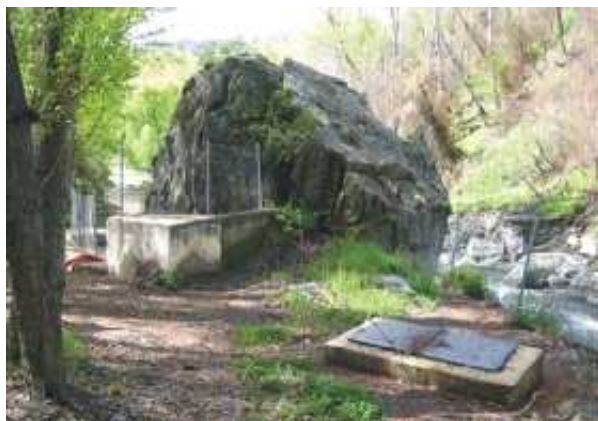
Galería de Agua Agria, arqueta (IGME Granada, 2003)
