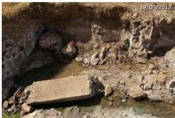
Manantial de los Baños del Búho, restos del pozo (A. Ventas, agosto 2017)
