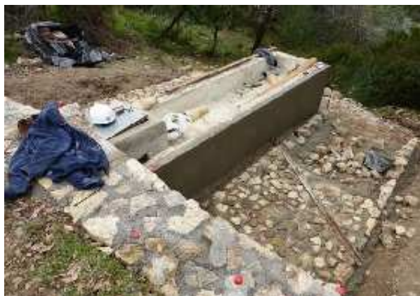
Abrevadero en fase de restauración (P. Sánchez Gil, febrero 2014)
