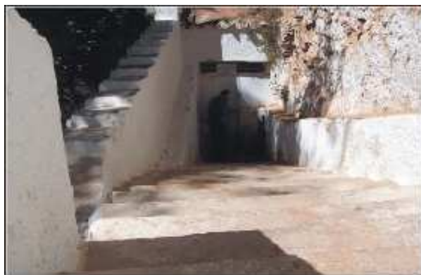
Manantial del Zangullo, entrada a la galería (IGME Granada)
