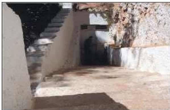
Manantial del Zangullo, entrada a la galería (IGME Granada)
