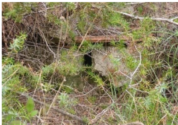
Toma de agua Prado Maguillo (J. D. Cano Cavanillas, octubre 2013)
