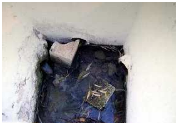
Manantial de Ciélagos (R. Córdoba, 1998)
