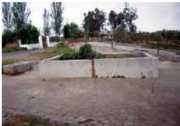
Pozo de las Cadenas (R. Córdoba, 1998)
