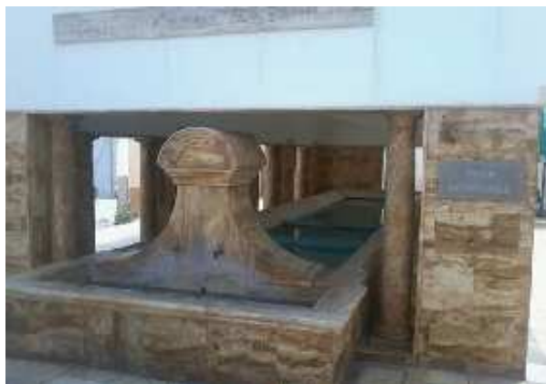
Lavadero de Benahadux (E. Milla, septiembre 2013)
