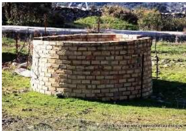
Pozo del Cercado (J. L. Valencia Oca, agosto 2013)
