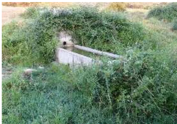
Pilón-abrevadero (P. Sánchez Gil, julio 2013)
