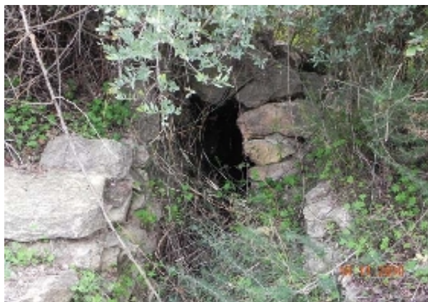
Fuente de las Arquillas, boca de la galería (J. Martín, noviembre 2010)
