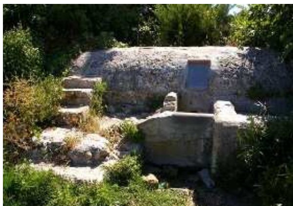
Fuente del Depósito de Santa Lucía (J. M. Amarillo, junio 2013)
