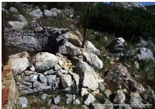
Detalle del pozo construido en piedra, se aprecia el rebose (J. L. Valencia, febrero 2013)
