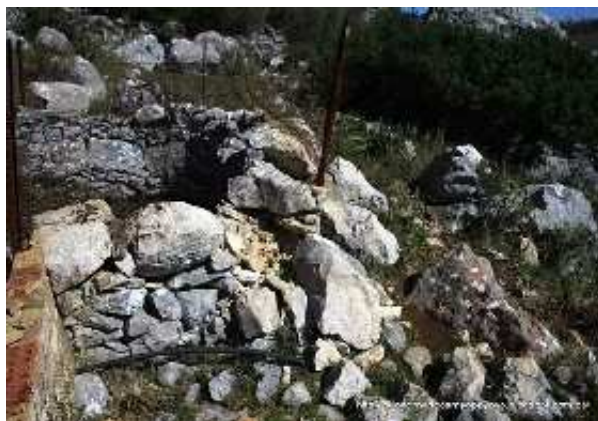
Detalle del pozo construido en piedra, se aprecia el rebose (J. L. Valencia, febrero 2013)
