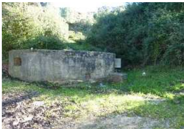
Pozo de captación (M. Cabello, marzo 2013)
