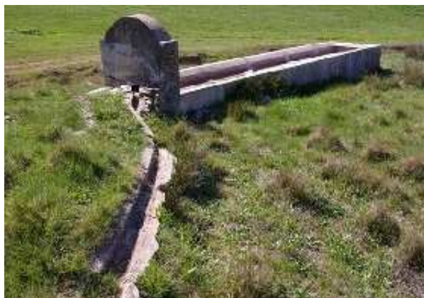
Fuente del Acebuchoso o Cerrillar (J. M. Amarillo, abril 2012)
