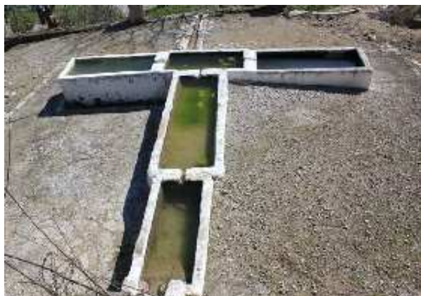
Abrevadero sobre el Arroyo de Berrio (J. A. Palomino León, febrero 2013)
