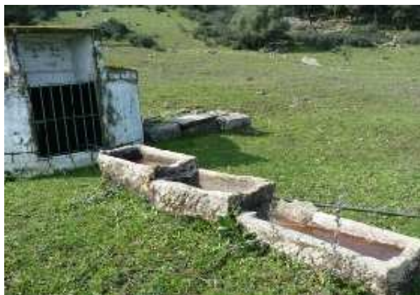
Fuente y pilones de las Tres Piedras (M. Cabello, febrero 2013)
