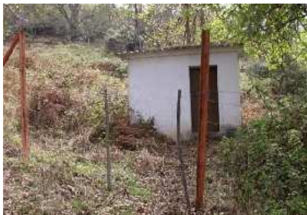
Manantial del Sotillo, caseta de protección (IGME-D.P. Jaén)
