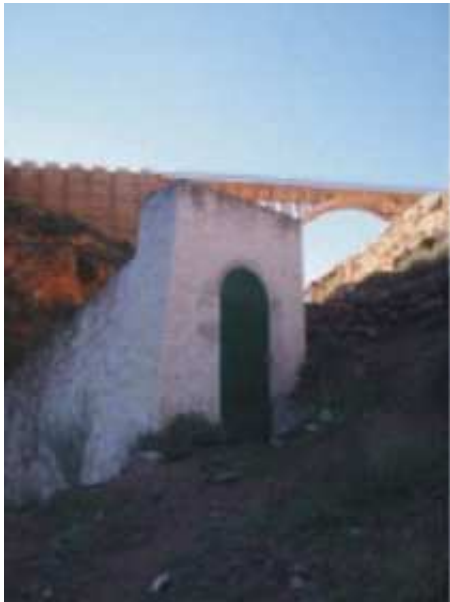
Manantial del Puente de la Cerrada ( www.igme.es , 2008)
