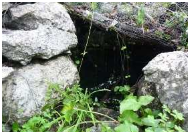
Interior del Pozo de la Huerta de Carretero (M. Cabello, enero 2013)
