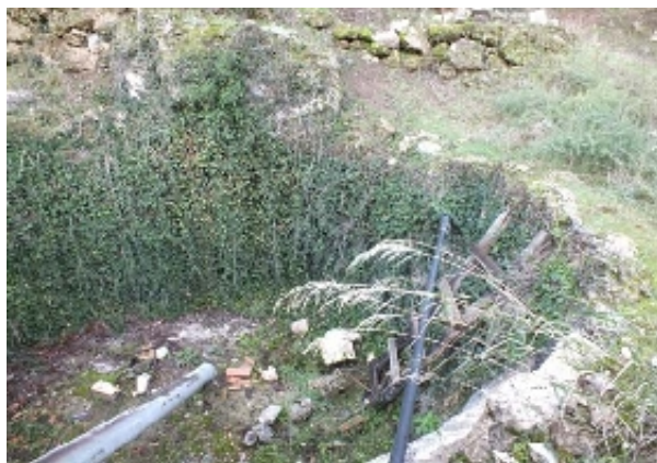
Alberca y tubería (J. D. Cano Cavanillas, enero 2013)
