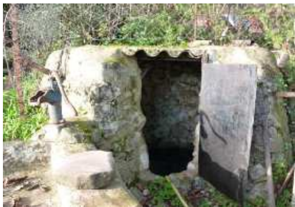
Pozo del Peñón de la Esquina (M. Cabello Izquierdo, enero 2013)
