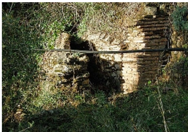
Vista exterior de la galería de la mina (A. Vela Torres, octubre 2012)
