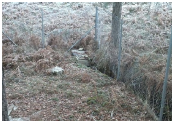
Fuente de Los Prados de Mesta II, toma de agua (J. D. Cano Cavanillas, diciembre 2012)
