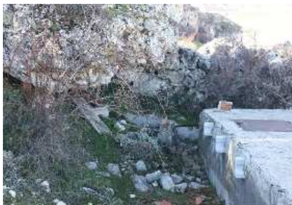
Fuente del depósito de Loma Gérica (L. Cano Cavanillas, diciembre 2012)
