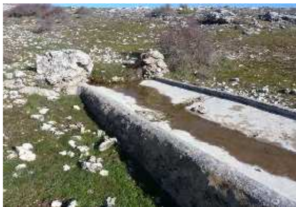
Pozo de Purga (L. Cano Cavanillas, diciembre 2012)
