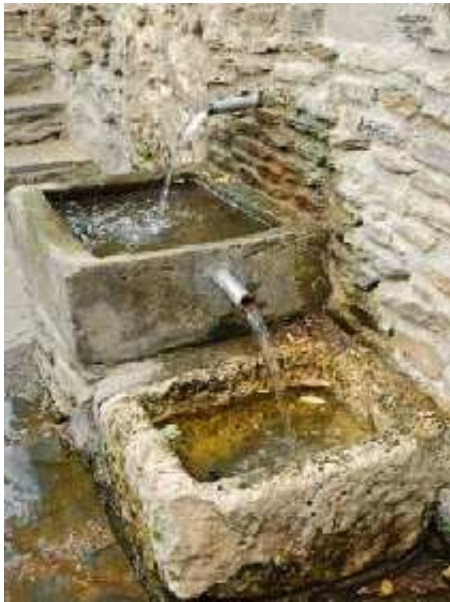
Fuente de la Pileta, detalle de las dos pilas de cantería (J. M. Fernández Portal)
