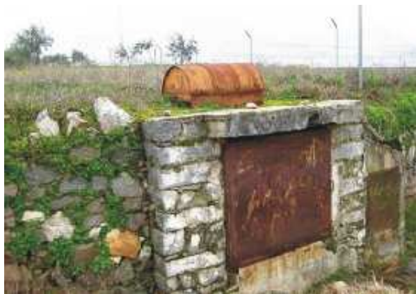
Pozo del Camino Ancho (F. Romero Romero mayo 2009)
