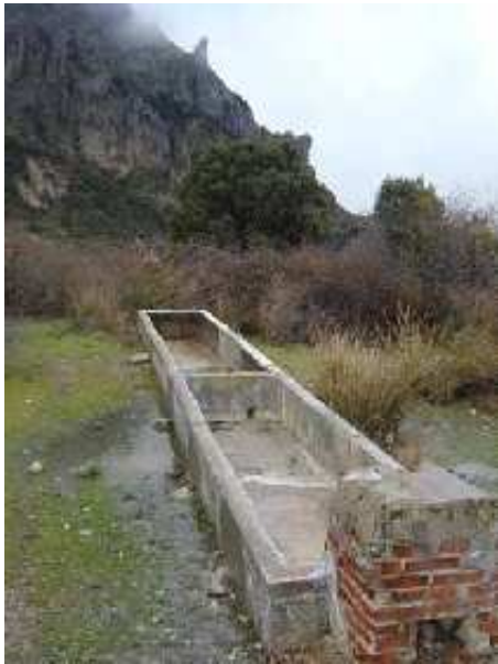
Fuente del Tío Ratón deteriorada tras la captación realizada para abastecimiento a Pegalajar (D. Polo, enero 2009)
