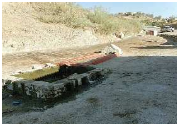
Pilar de los Frailes, vista general (A. Vela Torres, septiembre 2012)
