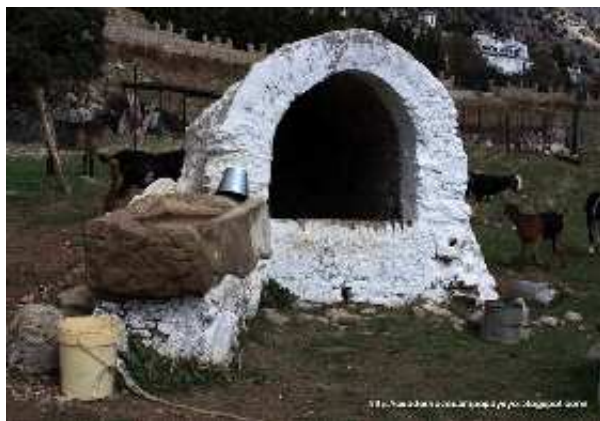
Pozo del Prado, vista frontal (J. L. Valencia, octubre 2012)
