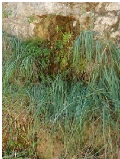
Rezume del Cuarto Puente (L. Cano Cavanillas, agosto 2012)
