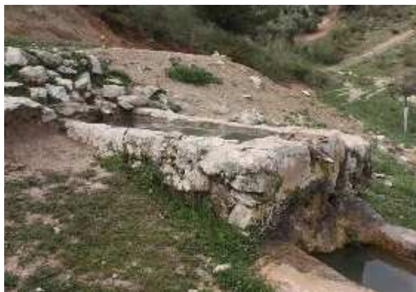
Pilón de Arcos (B.Montes, mayo 2012)
