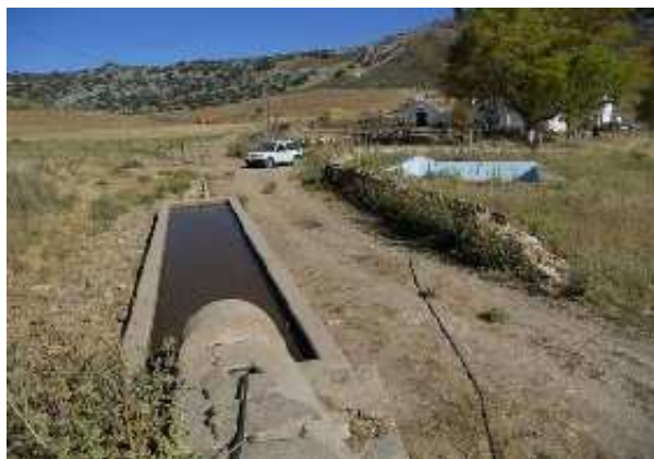
Abrevadero del Cortijo de Las Pilas (S. Rodríguez, junio 2012)
