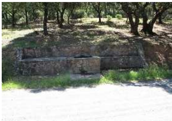
Vista del pilar al borde del camino (F. Sancho, mayo 2012)
