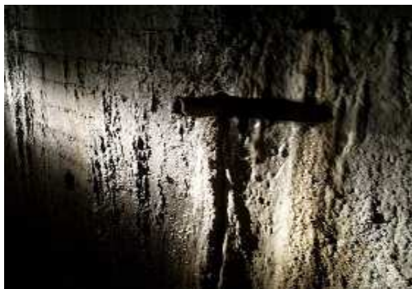
Fuente del Tunnel del Cementerio (F. Usero Cerdán, abril 2012)
